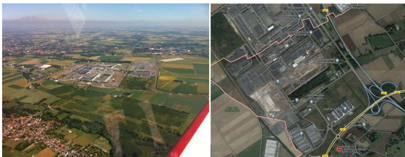
La vue aérienne de l'usine Renault lors de sa construction entourée de terres agricoles en 1973 à gauche une vue aujourd'hui de ce site qui est encore en développement à droite.
